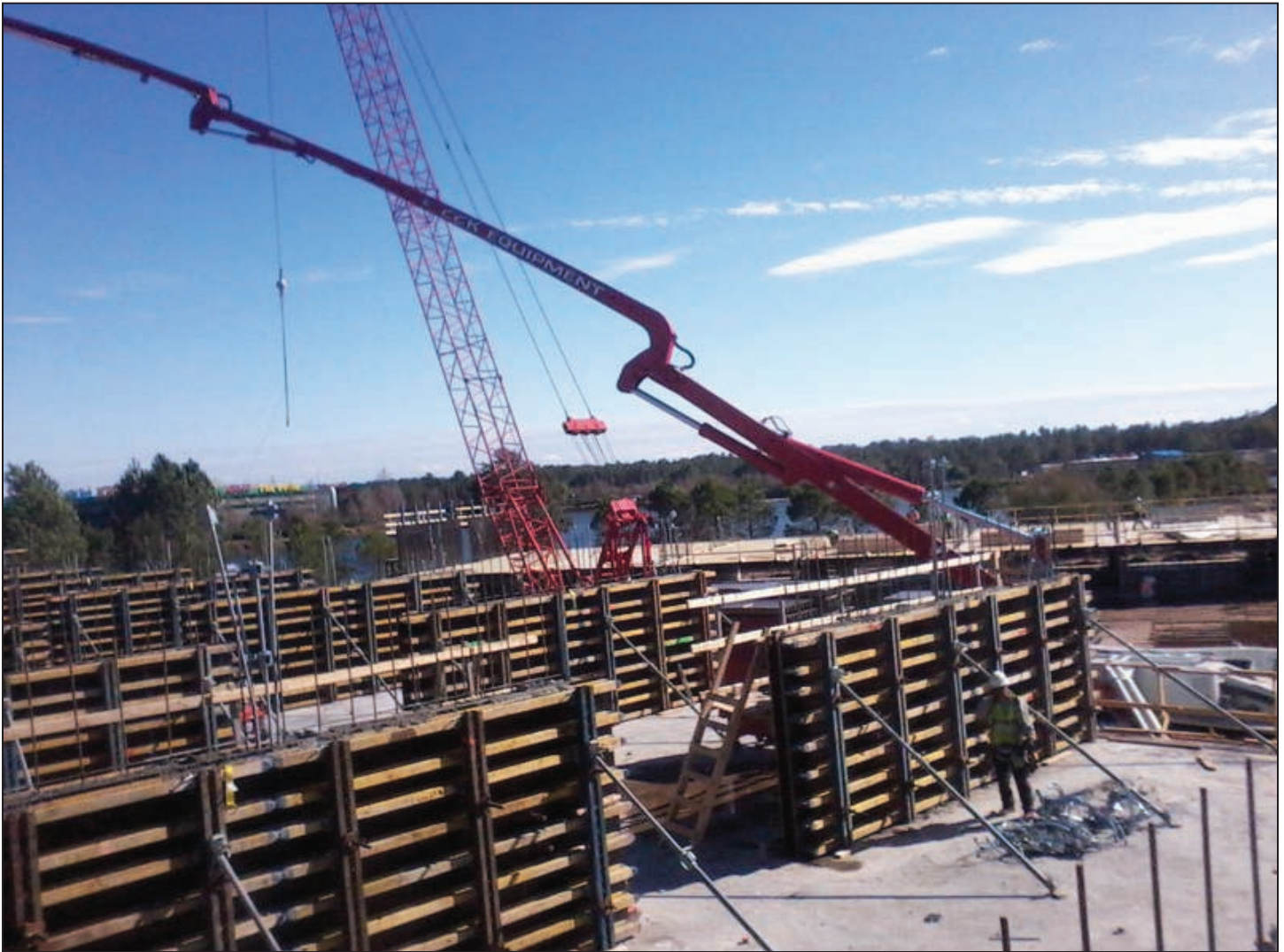
ongoing concrete pours
